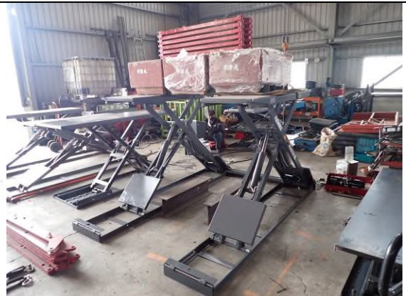
照片“D” 荷重測試
