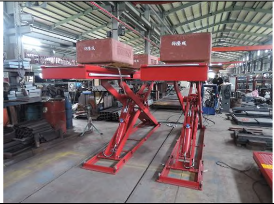
照片“H”荷重測試
